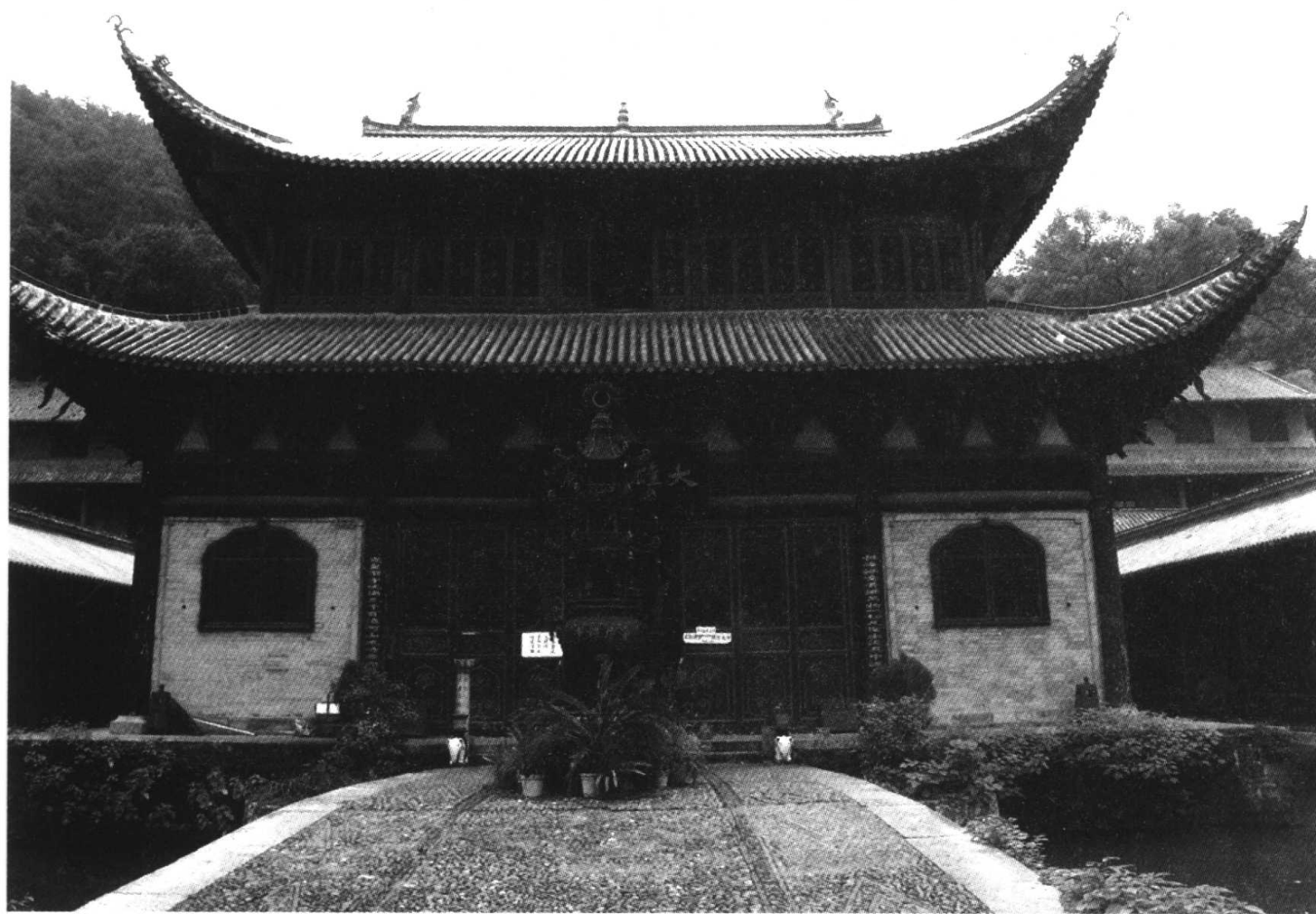
修复后的净居寺大雄宝殿
